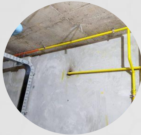
Instalación red media presión
