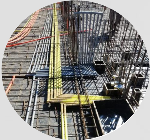
Instalación red baja presión
